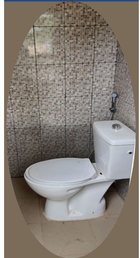
Construction de latrines
